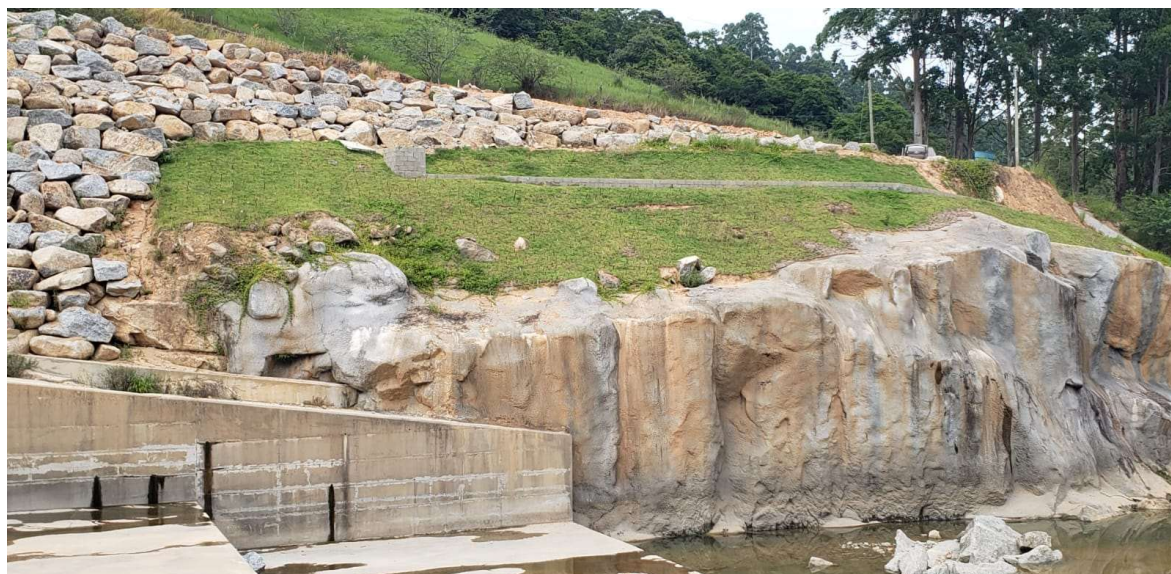
Foto 8 – Foto dos tratamentos realizados na margem esquerda do Canal de Dissipação.
