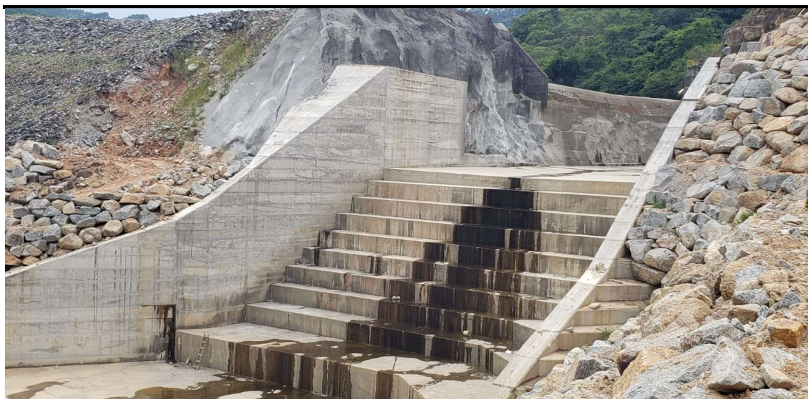
Foto 5 – Vista da Escada de dissipação do vertedouro de soleira livre na margem esquerda. Foto com a estrutura recuperada e finalizada
