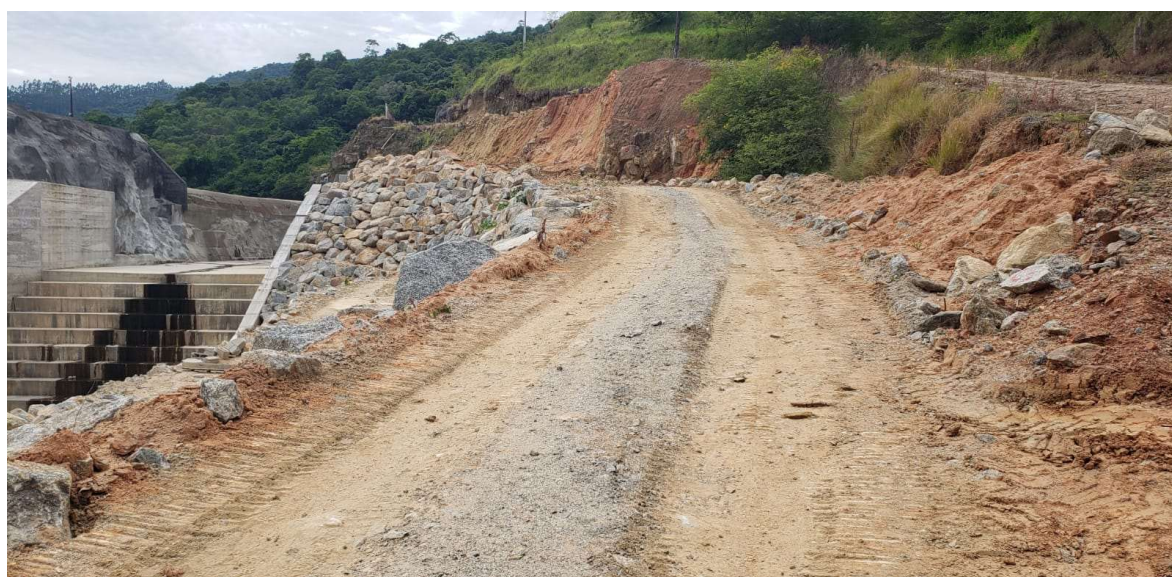
Foto 10 – Estrada de Acesso à tomada d'água da PCH Capivari.
