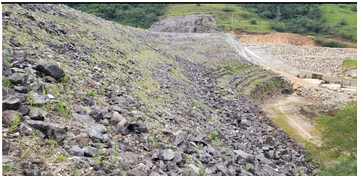
Foto 1 – Vista do talude de jusante da barragem de enrocamento com núcleo argiloso a partir da margem direita.
