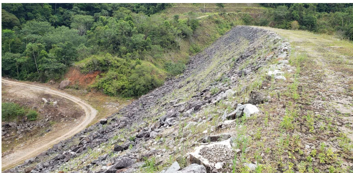
Foto 14 – Vista da Ombreira Direita da Barragem.
