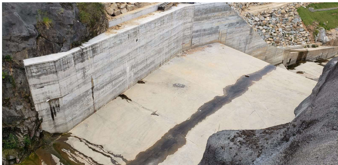
Foto 6 – Detalhe dos tratamentos realizados no piso do canal de dissipação do vertedouro.
