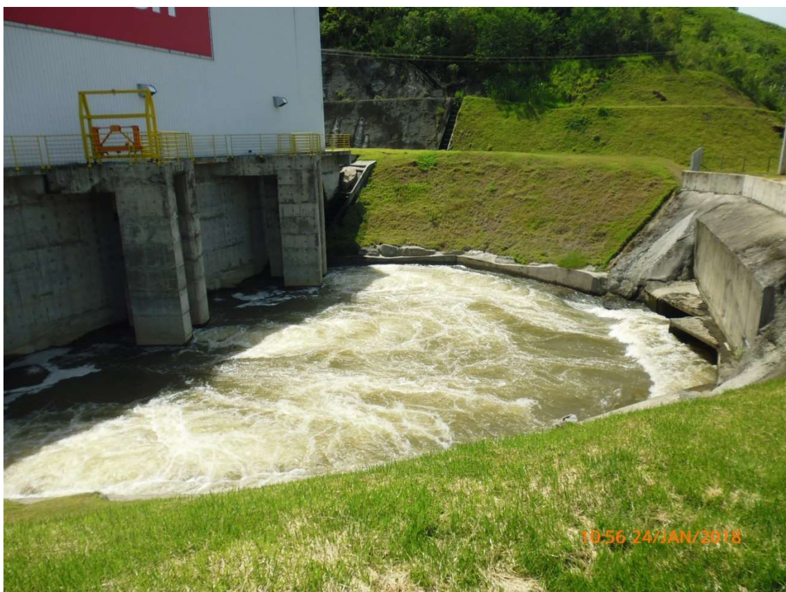
Foto 13 – Vista do canal de fuga das três unidades geradoras da casa de força.
