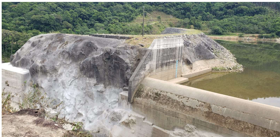
Foto 4 – Vista do vertedouro de soleira livre e tomada d'água na margem esquerda, com o NA do reservatório na el.178,00m.
