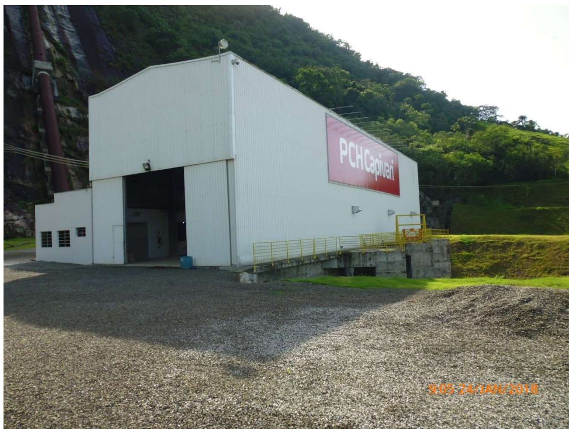
Foto 14 – Vista geral da casa de força da PCH Capivari.
