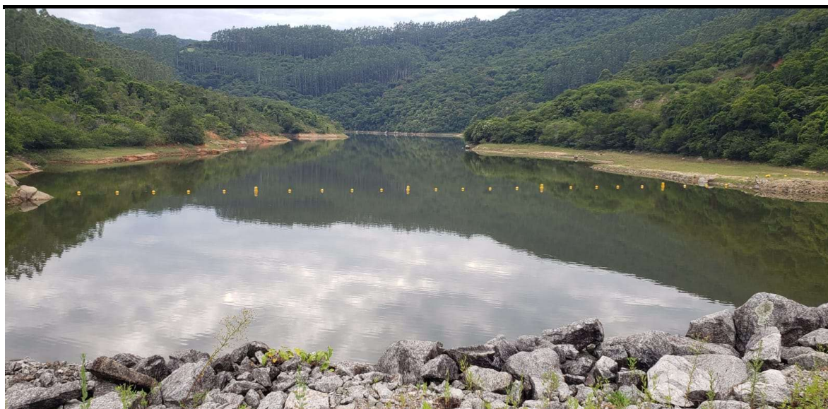
Foto 3 – Vista do reservatório a partir da crista da barragem de enrocamento com núcleo argiloso.
