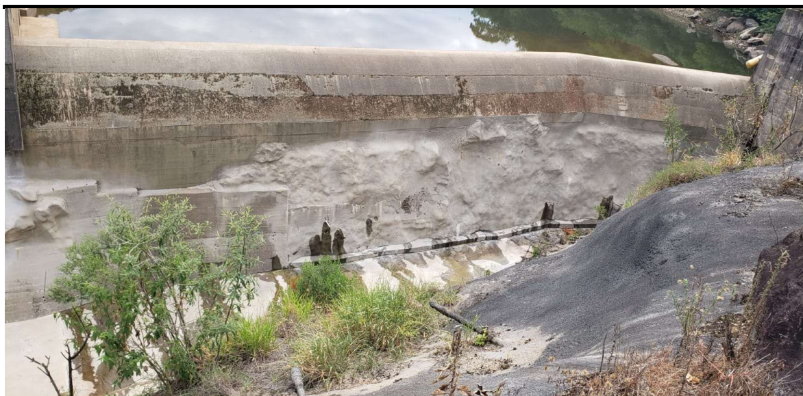
Foto 9 – Vista dos tratamentos realizados abaixo da Soleira Vertente.
