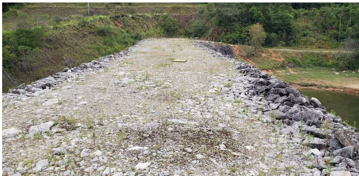
Foto 2 – Vista da crista da barragem de enrocamento com núcleo argiloso a partir da margem direita e com o nível d'água do reservatório na el.180,00m.
